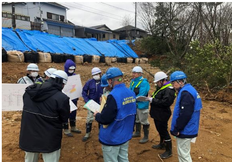
現場調査状況(石川県能美市)
